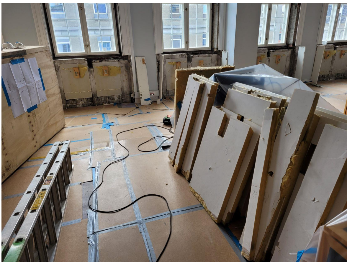
Sø- og Handelsrettens Retssal B under renovering
